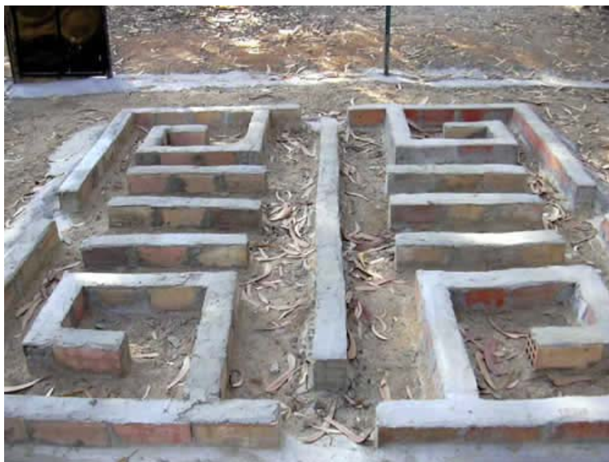
Otro detalle de vivares de obra de ladrillos con interior organizado en forma de laberinto.
