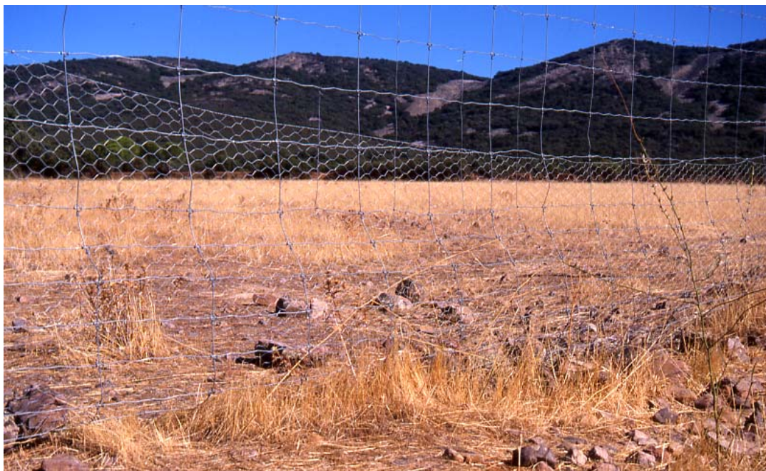
Detalle del vallado perimetral con las dos mallas solapadas.
