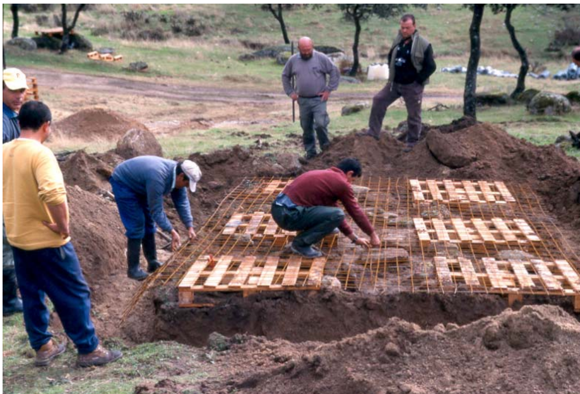
Refuerzo con mallazo de construcción en la parte superior y laterales del vivar para evitar la predación. Se observan también las piedras instaladas entre los palets.
