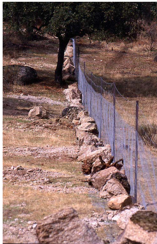
Diferentes fotografías de vivares (abajo) y refugios (izquierda, arriba) terminados, con la cubierta de matorral y piedras y detalle del vallado perimetral protegido con piedras
