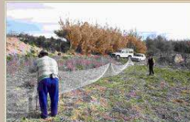
Construction de clôtures pour les lapins Enclosure of rabbits hutches
