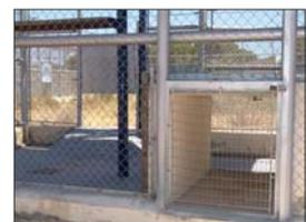
Para paliar el problema de la falta de conexión entre las instalaciones de la derecha con las de la izquierda, se ha construido un pasillo de comunicación que se puede colocar entre dos jaulas de manejo opuestas. Este sistema permite mover a los animales entre las instalaciones sin necesidad de capturarlos.
