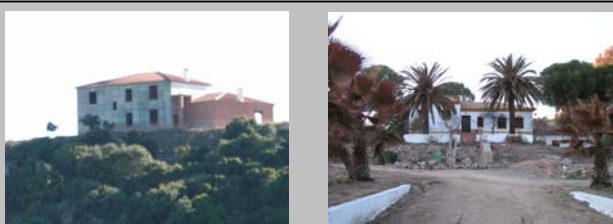
Construção na área de presença de lince em Andújar, Fevereiro de 2005
