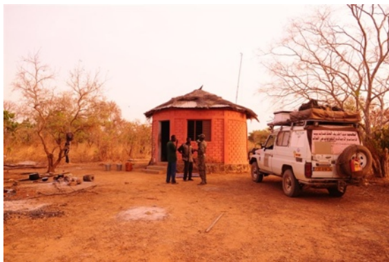
Le poste de Sapeingou
